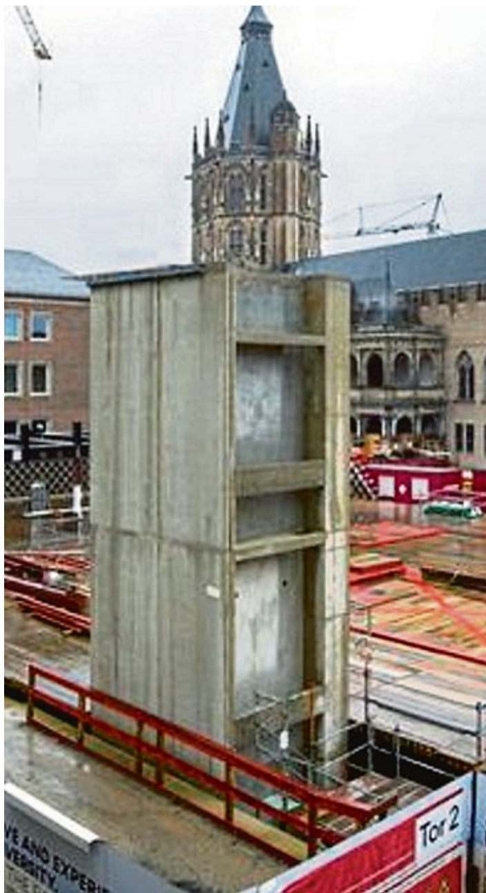
Im Bau: Archäologische Zone und Jüdisches Museum vor dem historischen Rathaus Foto: Bause
